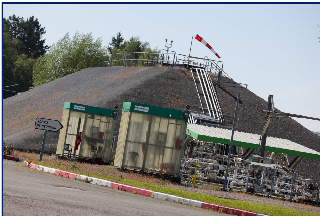
La fermeture du dépôt de gaz Antargaz s'accompagnera d'un démantèlement des installations.
