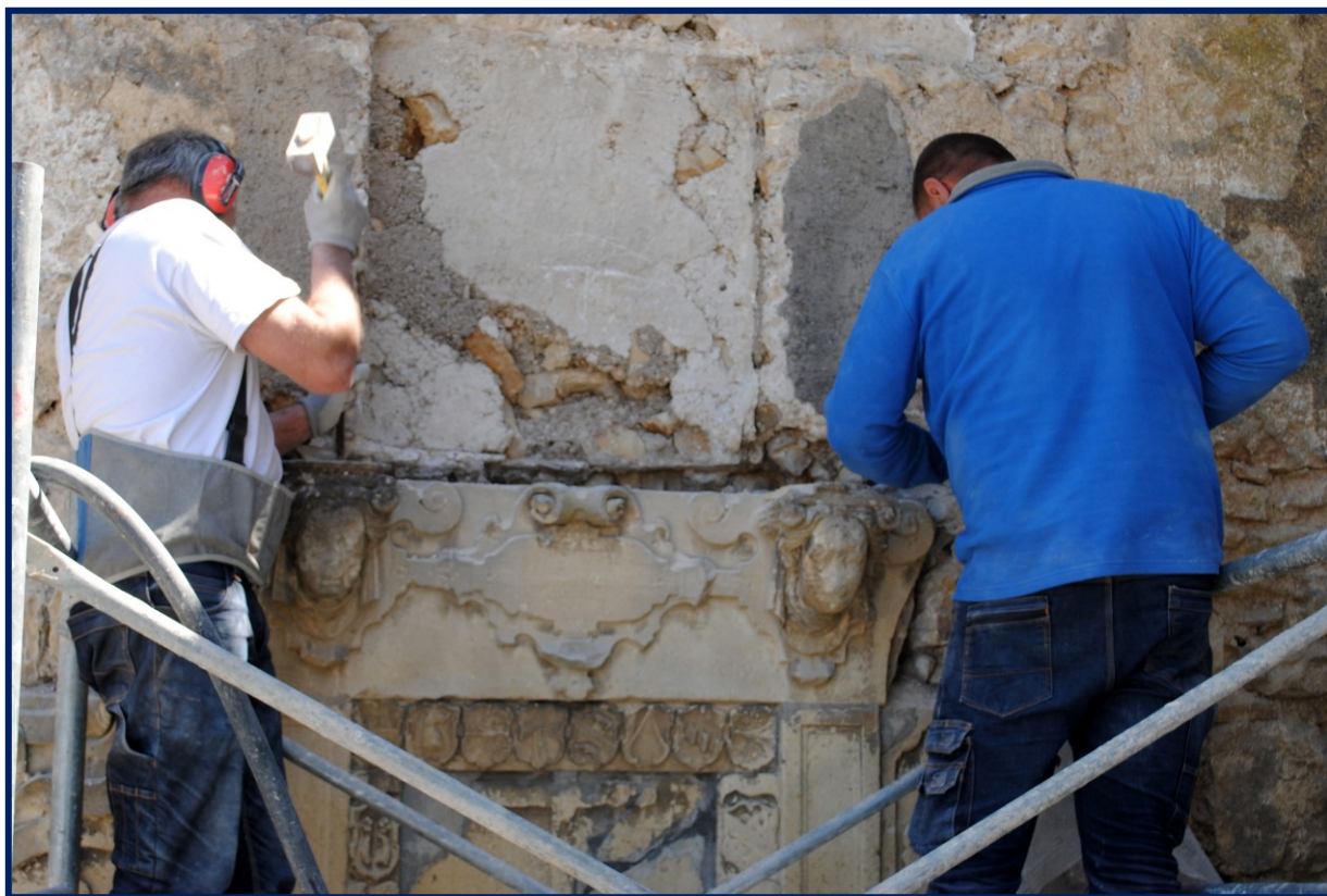
Daniel et Dominique creusant avec minutie derrière la partie à démonter.
