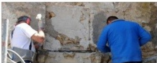
Daniel et Dominique creusant avec minutie derrière la partie à démonter.
