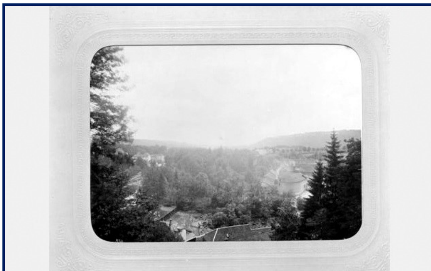
Vue d'ensemble depuis le nord, à la fin du 19e siècle.
