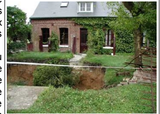
Conséquence d'un affaissement (Somme) – (Source : BRGM)
