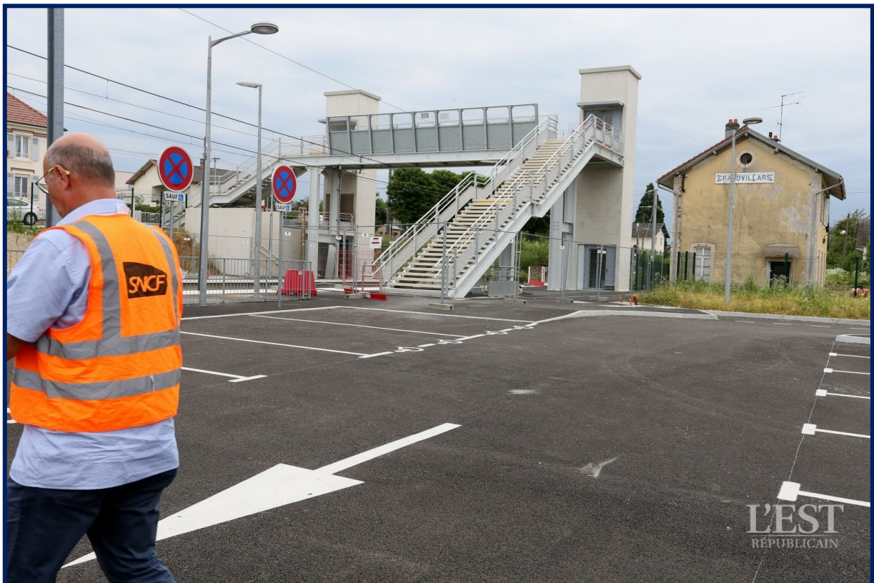
À Grandvillars, deux escaliers et deux ascenseurs ont été aménagés.
