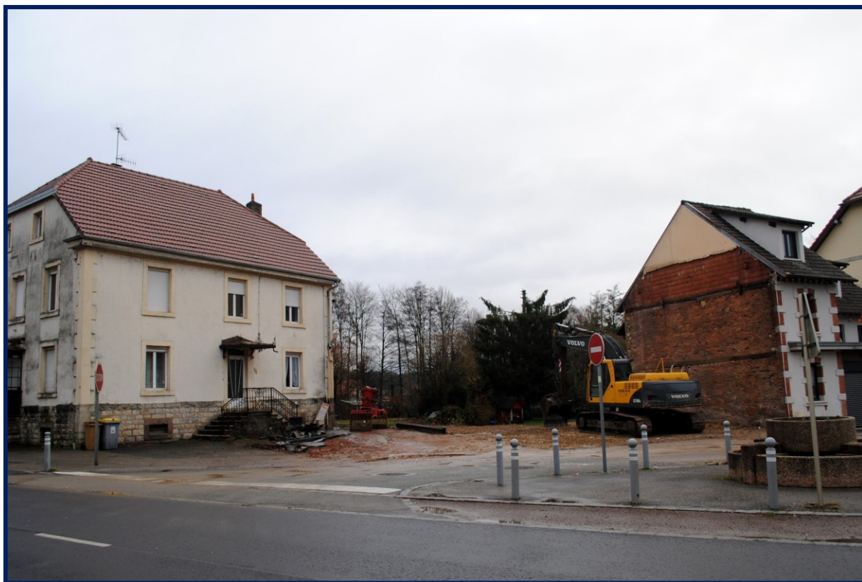
Le Coq D'Or maintenant. Fin 2019, ce lieu accueillera un cabinet médical.
