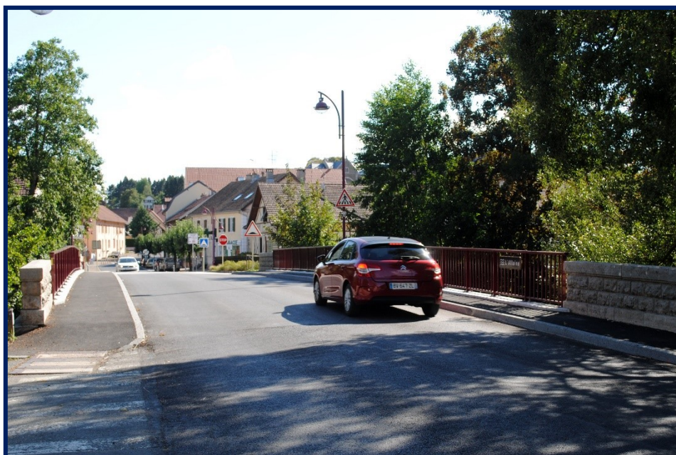
Le pont et la route sont impeccables.
