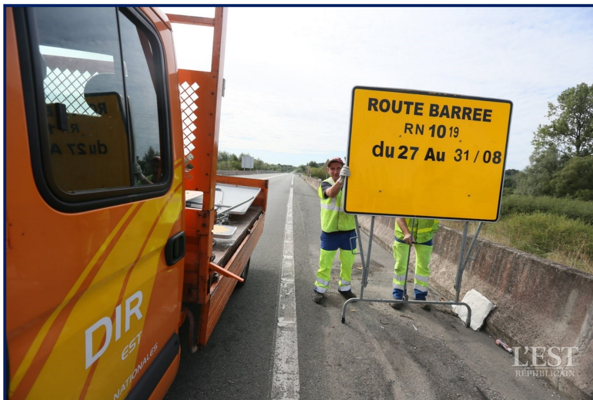
Les travaux concernent la section de la RN 1019 comprise entre les échangeurs de Morvillars/Grandvillars et Fêche-l'Église/Delle. Photo Christine DUMAS
