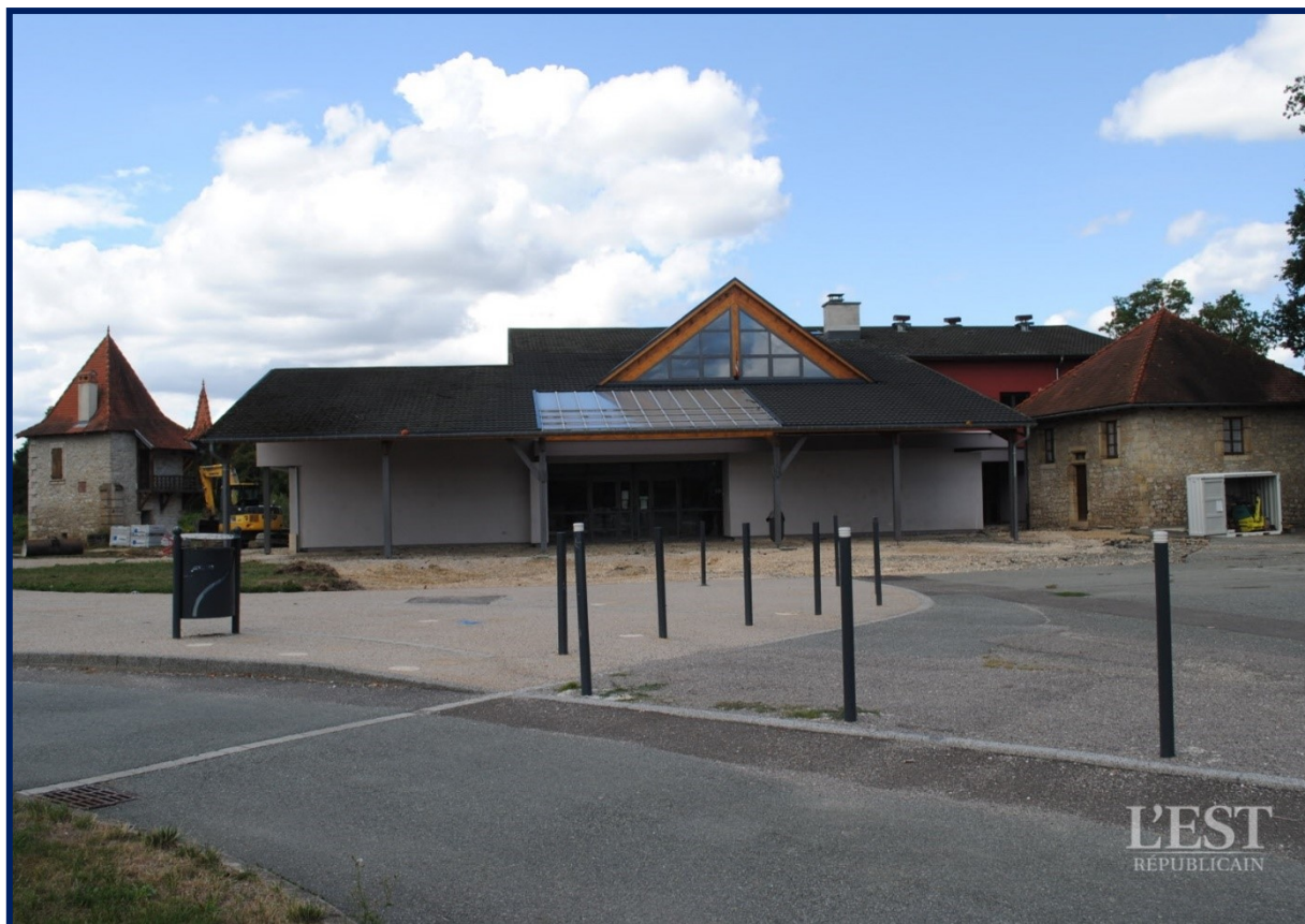
Les deux tours de « La Maison Forte » avec les travaux sont en évidence.
