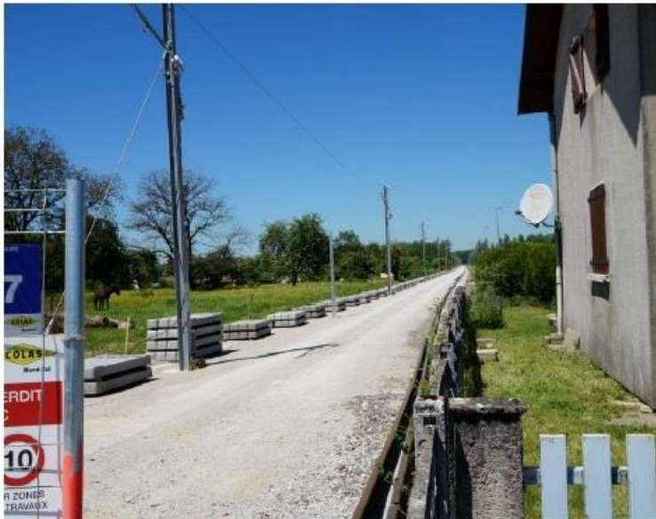
En direction de Morvillars, tout est prêt pour la pose de la voie.
