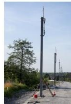
Les poteaux destinés à porter les caténaires sont installés.
