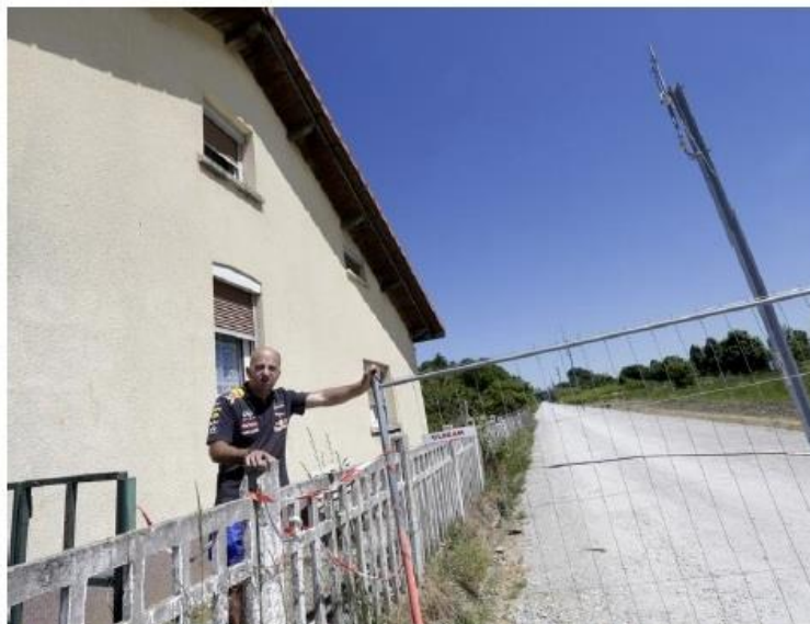
À Morvillars, la voie ferrée est en cours de construction au pied de la maison de Philippe Fradin. Photo Sam COULON
