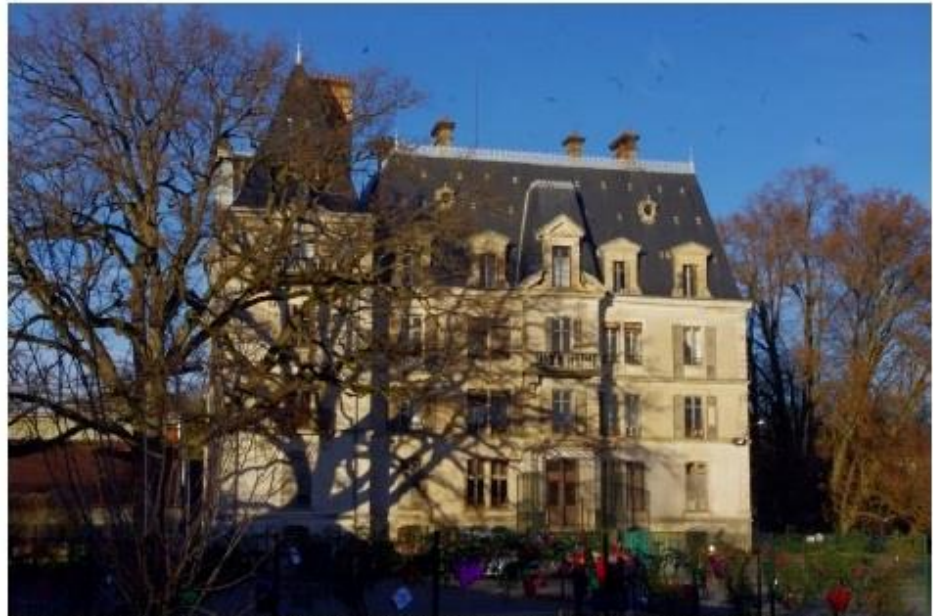
La requalification du Château, un dossier sur lequel la Sodeb pourrait être amenée à travailler en premier.
