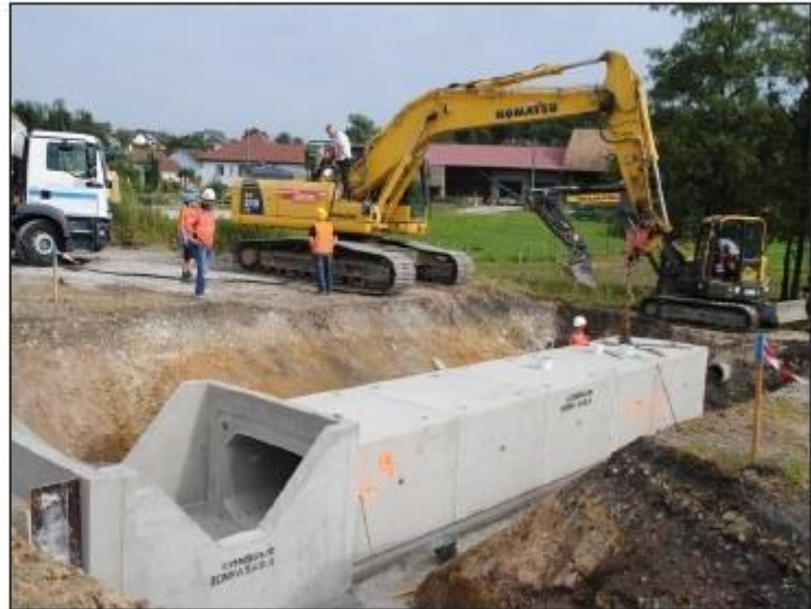
■ Un dalot est installé vers Point-P à Morvillars.
