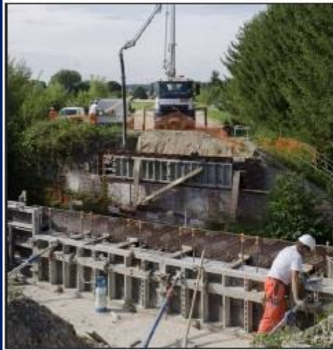
■ Le scellement de l'encrage du futur pont dans la partie existante.
