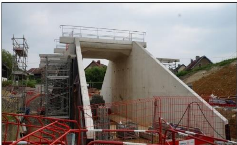
■ Le tablier central vient d'être coulé et les mains courantes posées.
