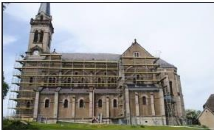
■ Préparation des échafaudages pour la restauration de l'église
