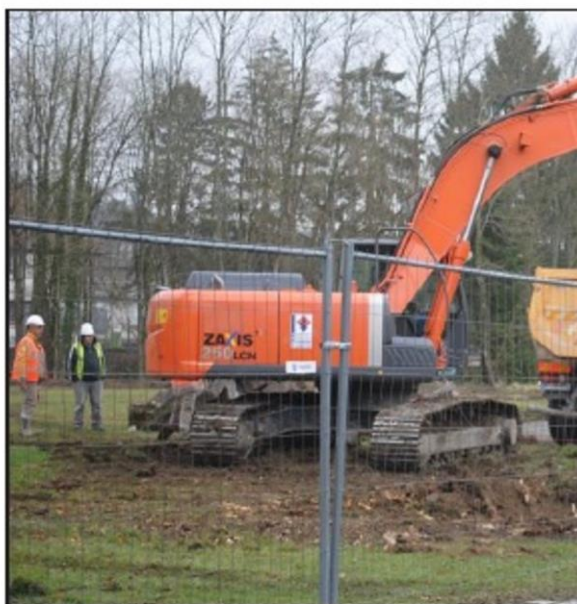
■ Hommes et engins ont commencé les travaux.
