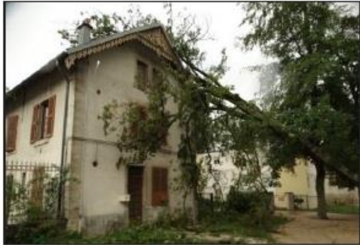
■ Les dégâts auraient pu être plus importants.
