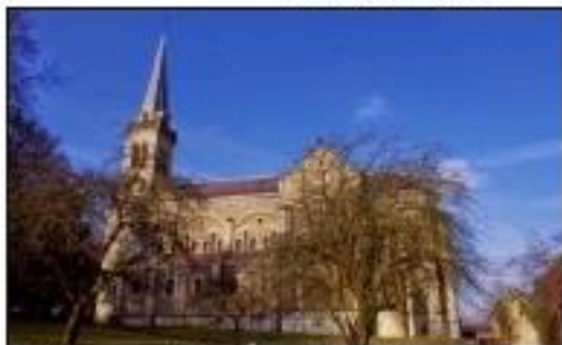
La toiture pourrait être renouvelée notamment grâce au plan Bâtiment de la Région.
