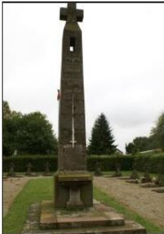
■ Le monument lanterne des morts a besoin d'une rénovation complète.
