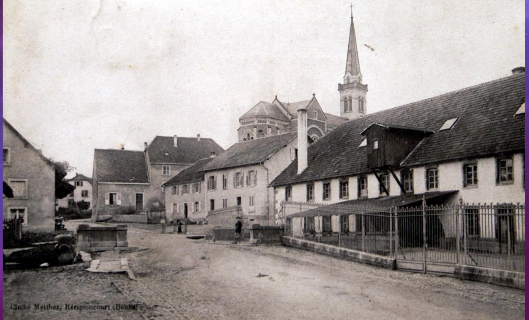
78. - Environs de Belfort. - MORVILLARS. - Quartier près des Usines
