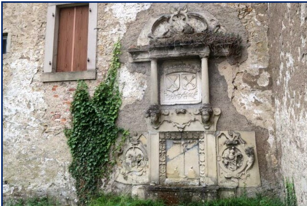
Le prieuré avant rénovation : en façade, la tombe de Walter d'Andlau, qui possédait la seigneurie de Morvillars au XVIIe siècle. Photo ER /Christine RONDOT
