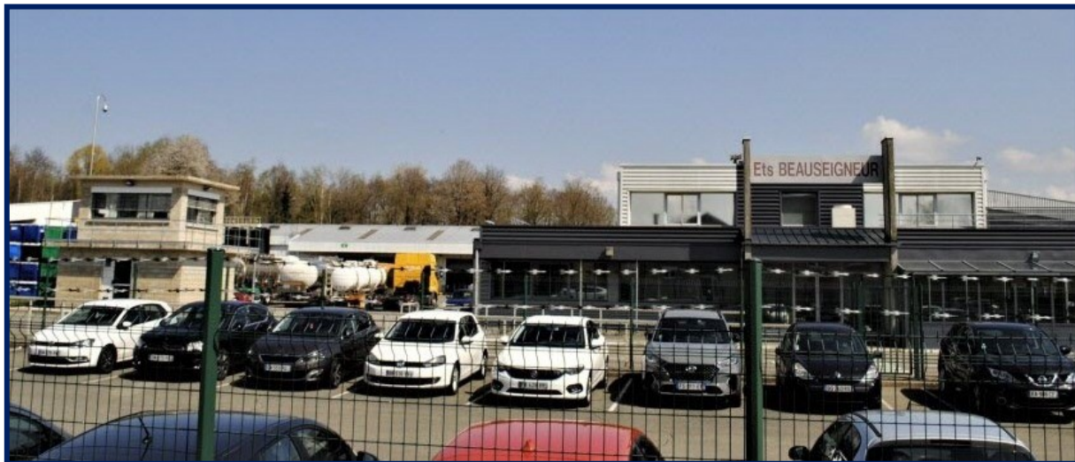
La société Beauseigneur relève du statut « Seveso seuil haut ».
