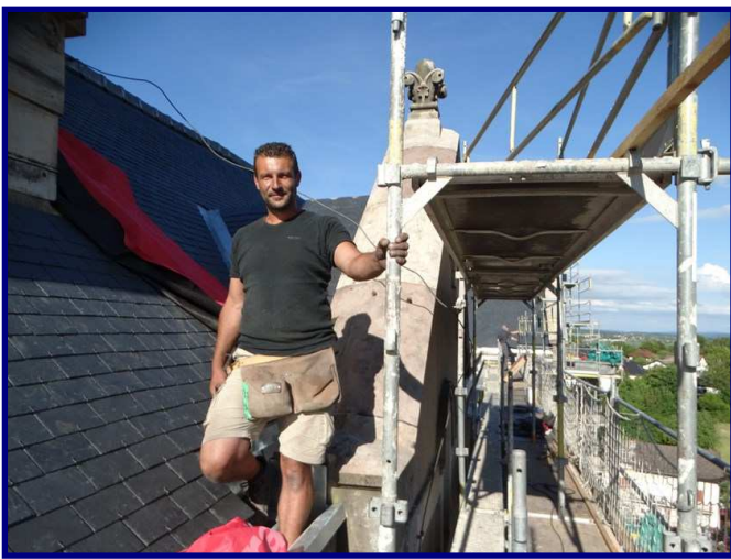
Travaux de l'église
