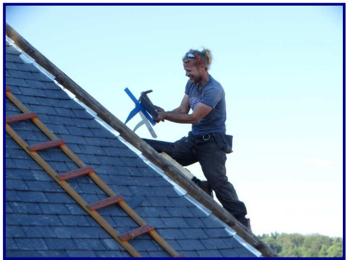
Travaux de l'église
