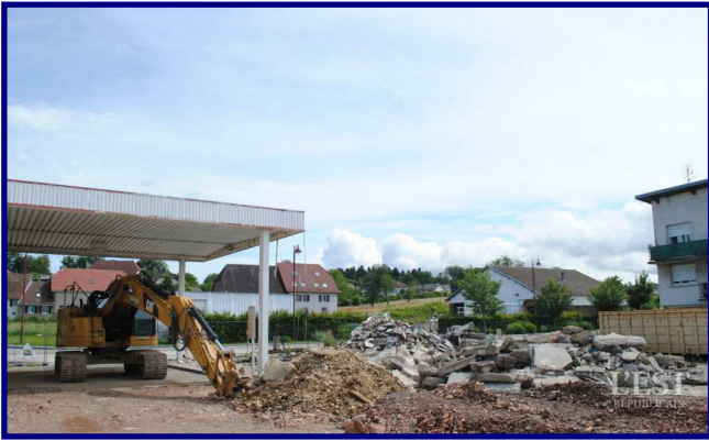
Dépollution de la station essence
