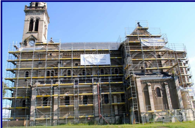
Travaux réfection toiture de l'église
