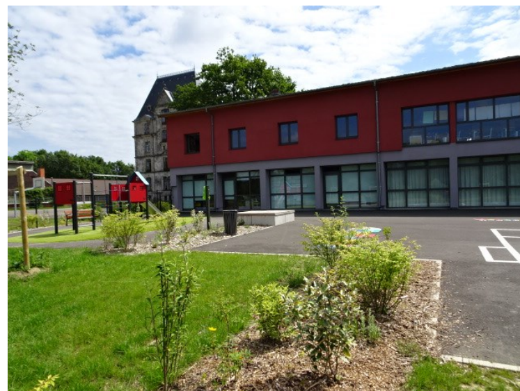
Cour arrière après les travaux
