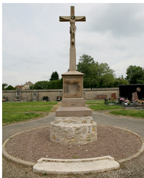
La croix et son socle qui avaient subi des dommages ont été entièrement rénovés par les deux communes.
