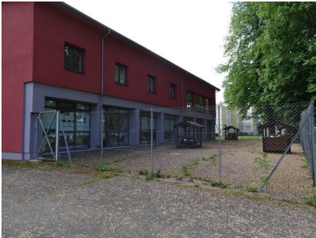
Cour arrière avant les travaux
