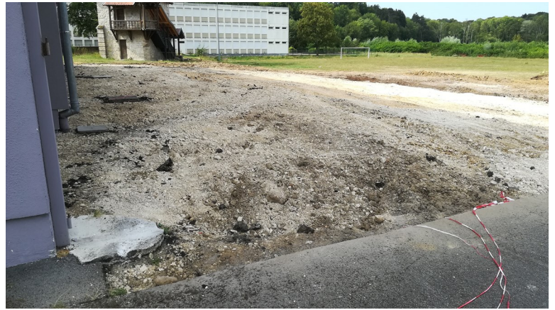
Cour arrière pendant les travaux
